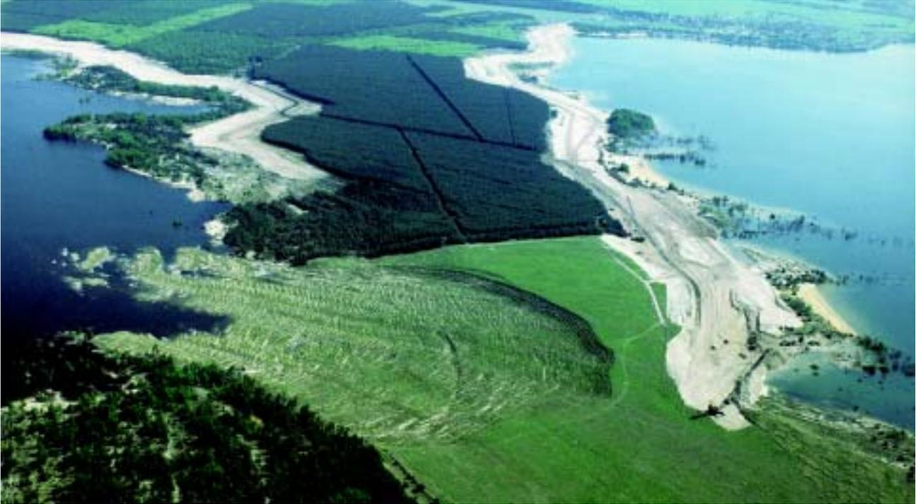
*Bild oben: Der Koschendammschlag nach einer Rutschung
