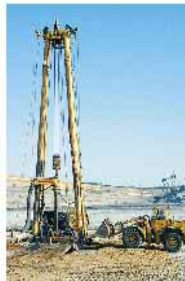
Einsatz eines Bohrgerätes im Tagebau zur Hebung des Grundwassers
