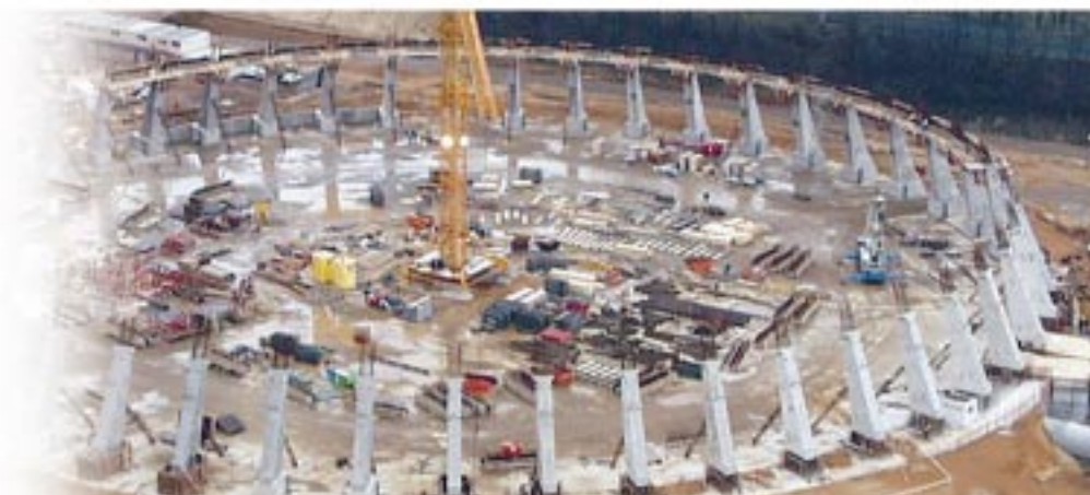
Neubau des RWE Energie Braunkohlenkraftwerkes Niederaußem, Foto RWE Energie
