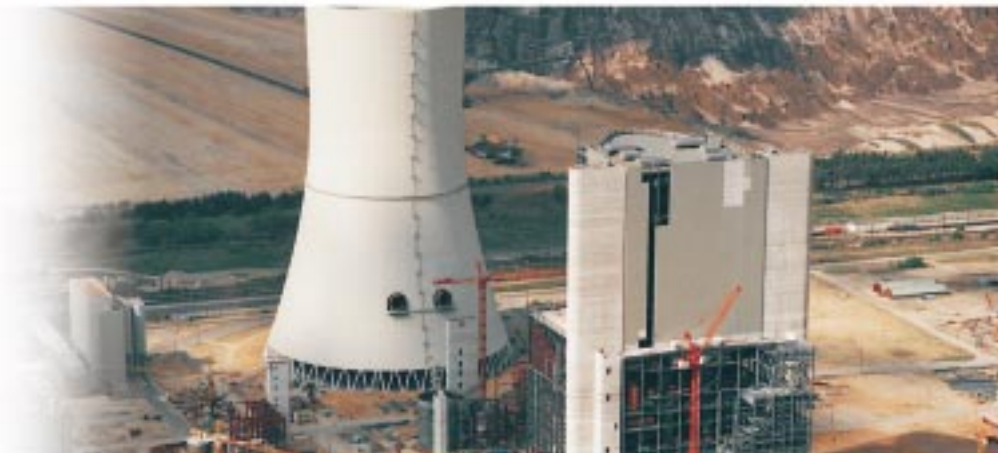
Neubau des VEAG Braunkohlenkraftwerkes Boxberg, Foto VEAG
