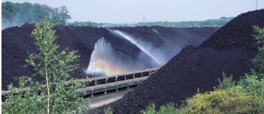
Staubbekämpfung im Kohlebunker
