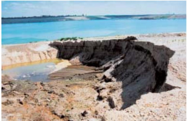
*Rutschung im Böschungsbereich am Tagebau Cosputen*
