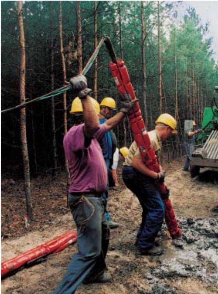
*Einbringen einer Sprengladung für die Sprengverdichtung*
