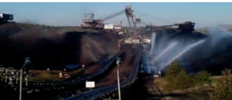
Staubbekämpfung im Kohlebunker
