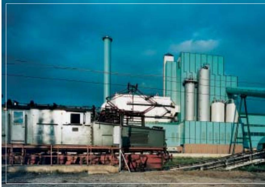
Der **Dampferzeuger** im Kraftwerk Wühlitz arbeitet nach dem modernen und umweltfreundlichen Prinzip der zirkulierenden Wirbelschicht (ZWS). Sie funktioniert auf der Grundlage von feinen Kohlepartikeln und hohen Luftgeschwindigkeiten. Der Brennstoff wird nahezu vollständig verbrannt. Die Restemissionen liegen weit unterhalb der gesetzlich geforderten Werte.
