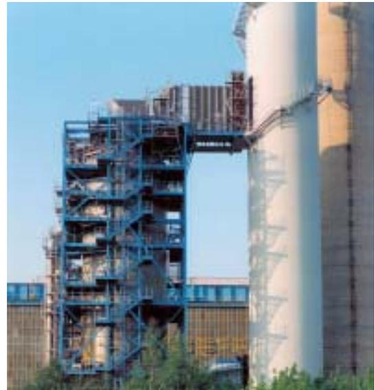
**Rauchgasentschwefelungsanlage (REA)** nach dem nassen Kalkstein-Additiv-Verfahren im Kraftwerk Mumsdorf. Sie reduziert die Schwefeldioxidkonzentration um mehr als 90 %.
