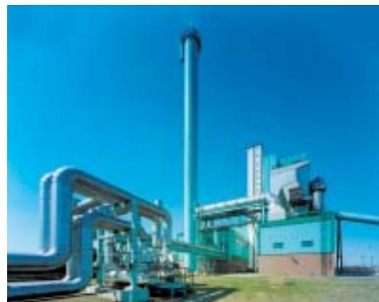
Die nachgeschaltete Doppelentnahme-Kondensationsturbine mit einer Leistung von 37,4 MW ermöglicht durch die Kraft-Wärme-Kopplung eine günstige Elektroenergieerzeugung. Die ausgekoppelte Wärme wird als Prozessdampf bzw. zur Fernwärmeversorgung verwendet.
