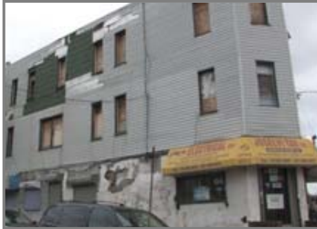
Ehemaliger Elektrofachbetrieb in New York
