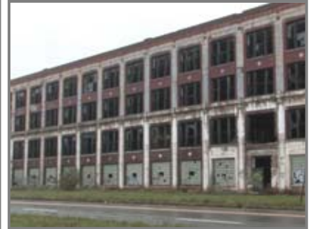
Geschlossene Automobilfabrik in Detroit
